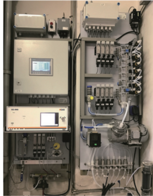
天然气管道网络中GC-IMS在线监测
