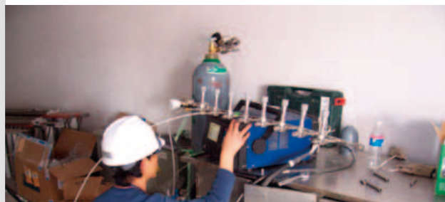
管路自动焊接
